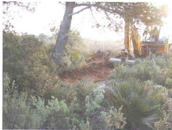
Foto 1: Vista dels treballs de delimitació.
